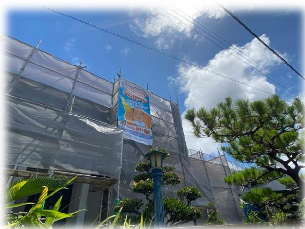
外壁塗装リフォーム現場
